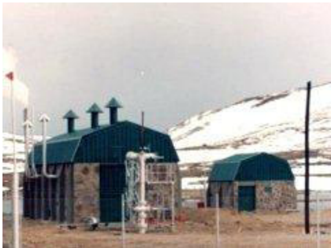
Central Geotermoeléctrica de Copahue ubicada en el pozo COP-1
